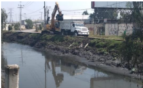
Deshierbe y retiro de basura en el dren 46. Valle de Chalco.
