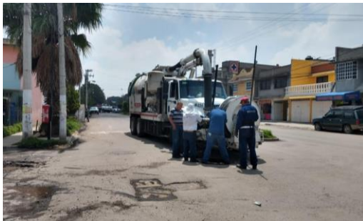
Desazolve de redes de drenaje. La Guadalupe, Ecatepec.
