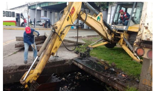
Retiro de basura de alcantarillas y limpieza de las cajas. Canal Zapata, San Mateo Atenco.
