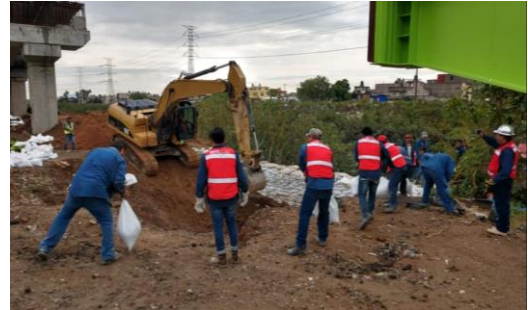
Reforzamiento del Gran Canal. San Miguel Xalostoc, Ecatepec.
