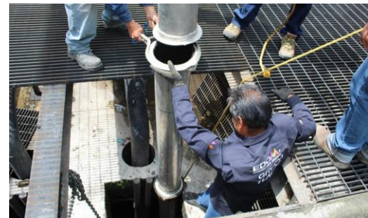
Desazolve del cárcamo de bombeo Colón. Av. Tollocan, Toluca.
