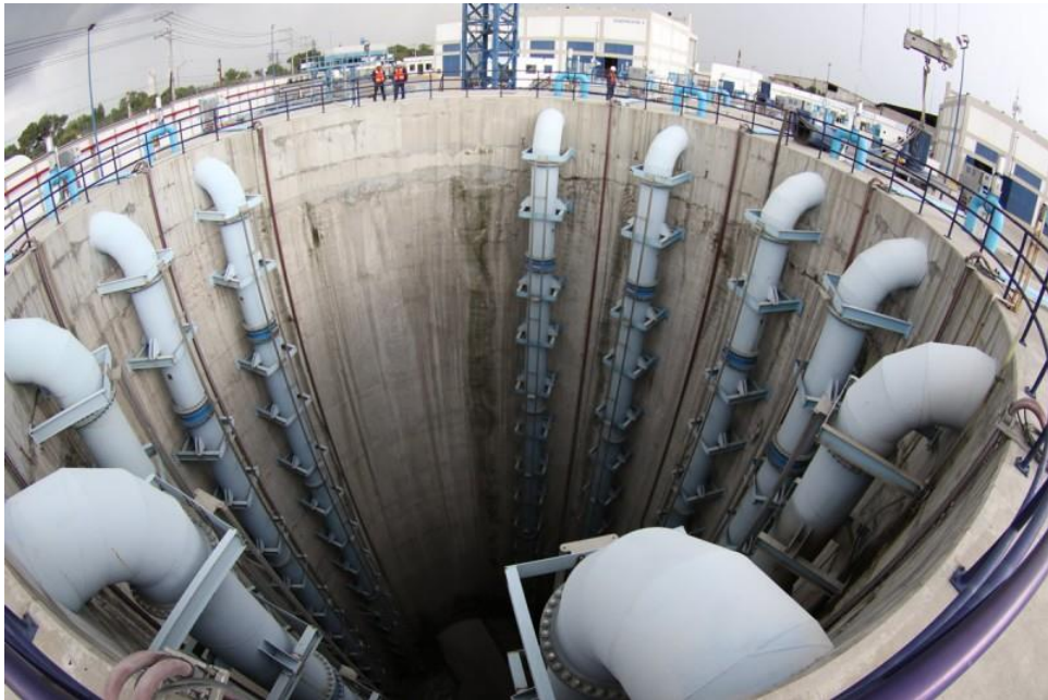
Túnel Emisor Oriente
